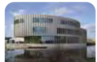
Anton de Komplein 240 10.00 uur Metro (halte Bijlmer Arena)
